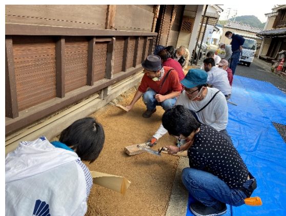
伝統的な建築の技術の高さと先人の知恵を体感する三和土づくり
