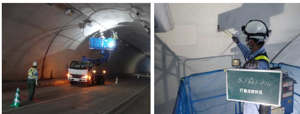
図2. 近接目視による点検状況
