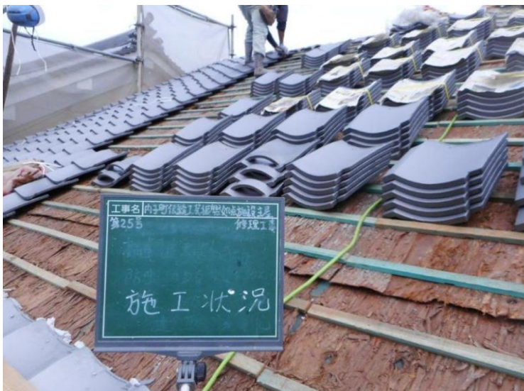
下_地域産瓦の施工状況
