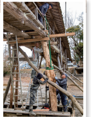
上_12月19日の改修工事に参加した皆さん 右_橋脚の付け替え作業。橋脚には丈夫で何十年も持つといわれる、栗の丸太が使われている。この丸太は石畳地区の山中を探し、ようやく見つけたものだそう。弓削神社の境内は町の名勝に指定されており、地域内外から多くの人が訪れる
