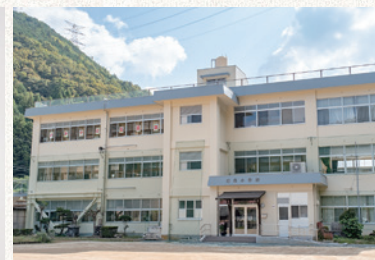
【石畳小学校耐震補強工事】 事業費：1億 1,006万円
