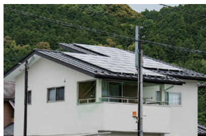
屋根に設置された太陽光パネル
