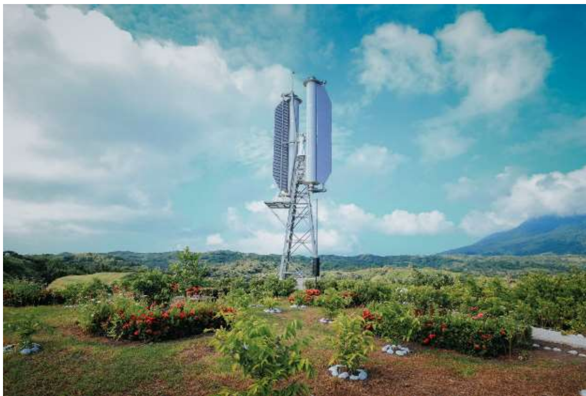
図 2-43：垂直軸型マグナス式風力発電機フィリピン初号機（出典 独立行政法人国際協力機構HP）
