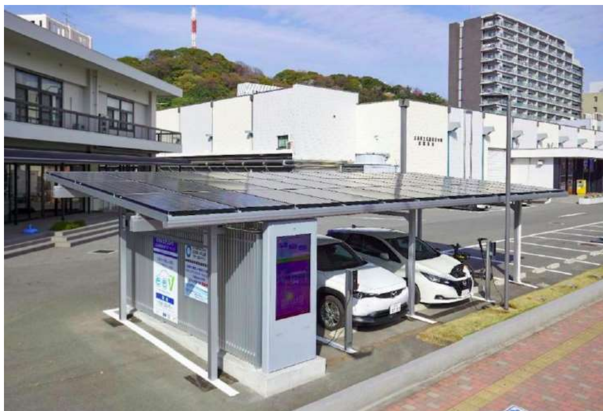
図 2-40：太陽光だけで稼働するEVステーション（出典 スマートジャパンWEBメディア記事）
