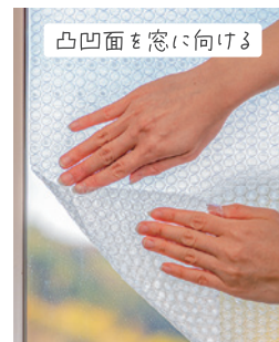
気泡緩衝材を窓に貼るのも断熱効果がある
