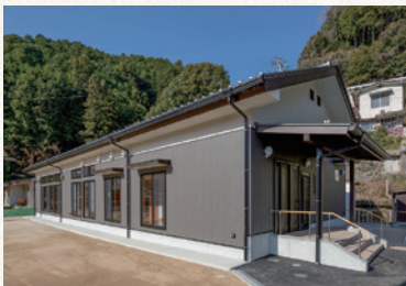
【和田自治会館新築工事】 事業費：7,481万円
