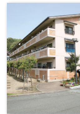
土居第2団地の外観
