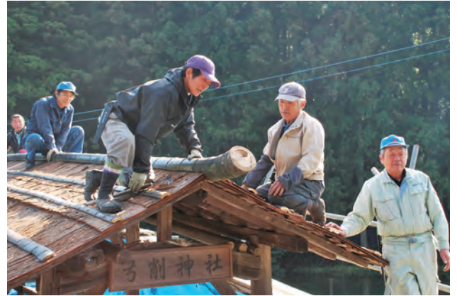
屋根付き橋の修理
