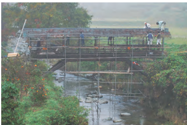
平成 25 年の田丸橋の屋根の葺き替え。概ね 8 年ごとに実施
