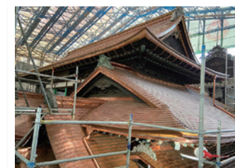
上_金づちでたたいて、銅板を加工する成岡さん 左_葺き替え工事で、あかがね色に輝く銅板屋根
