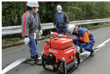
上_水利と火災現場が離れていると想定した約400mの中継送水 下_大洲市のホースを内子町の小型ポンプにつなげる
