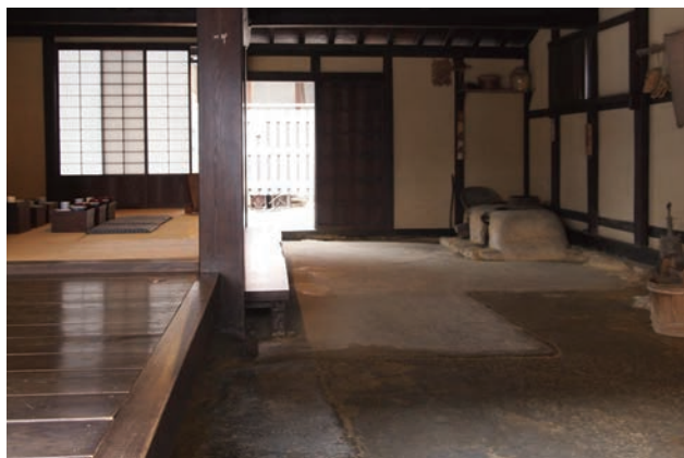
通り土間に並行した部屋の例（町家資料館）
