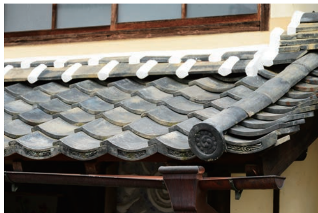
内子の歴史的建造物でよく使われているしのぎ棧瓦
