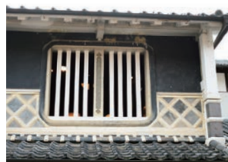
2階正面を鼠漆喰や海鼠壁で仕上げ、塗格子を施した例
