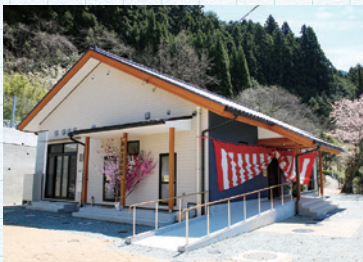
【南山自治会館解体新築工事】 事業費：8,766万円
